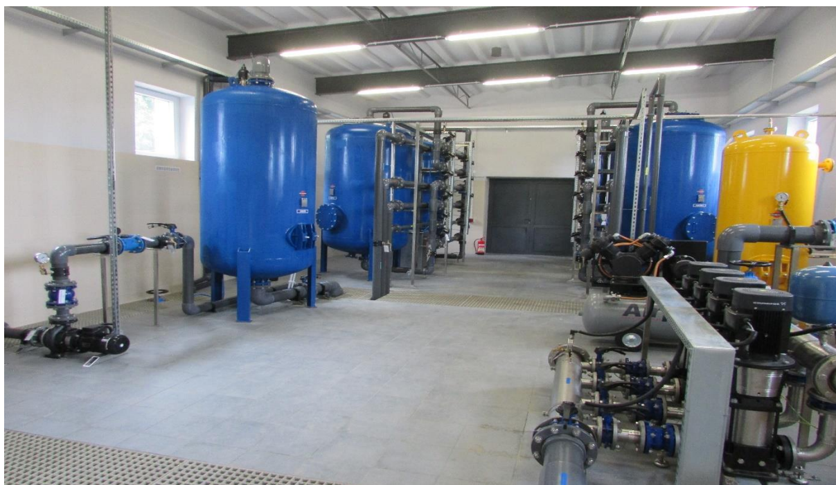
Zdjęcie Nr 8 Przebudowa stacji uzdatniania wody w miejscowości Morawin
