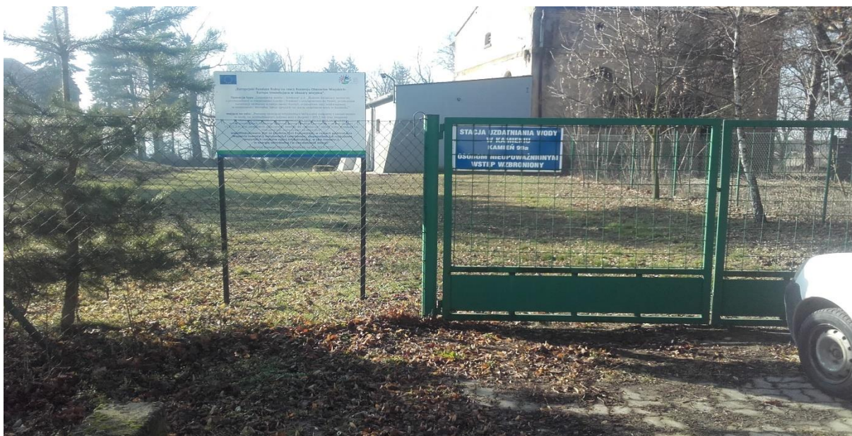
Rysunek nr. 8. Stacja uzdatniania wody przy zabytkowym spichlerzu w Kamieniu
