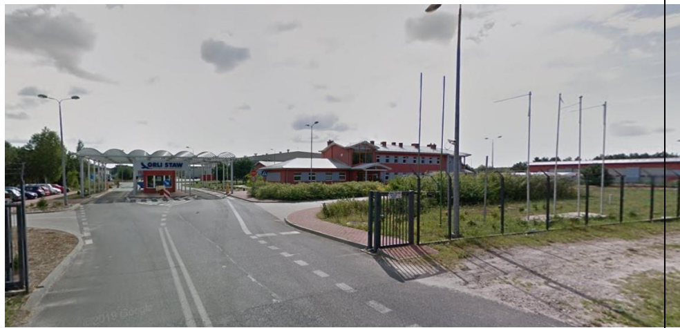
Zdjęcie 5. Zakład unieszkodliwiania odpadów „Orli Staw”
