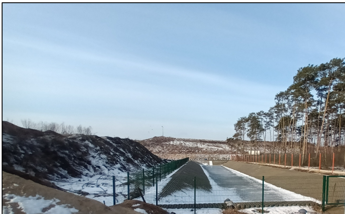
Ryc.6. Teren planowanej kompostowni (widok w kierunku zachodnim na część północną przedsięwzięcia), fot. ze stycznia 2026.
