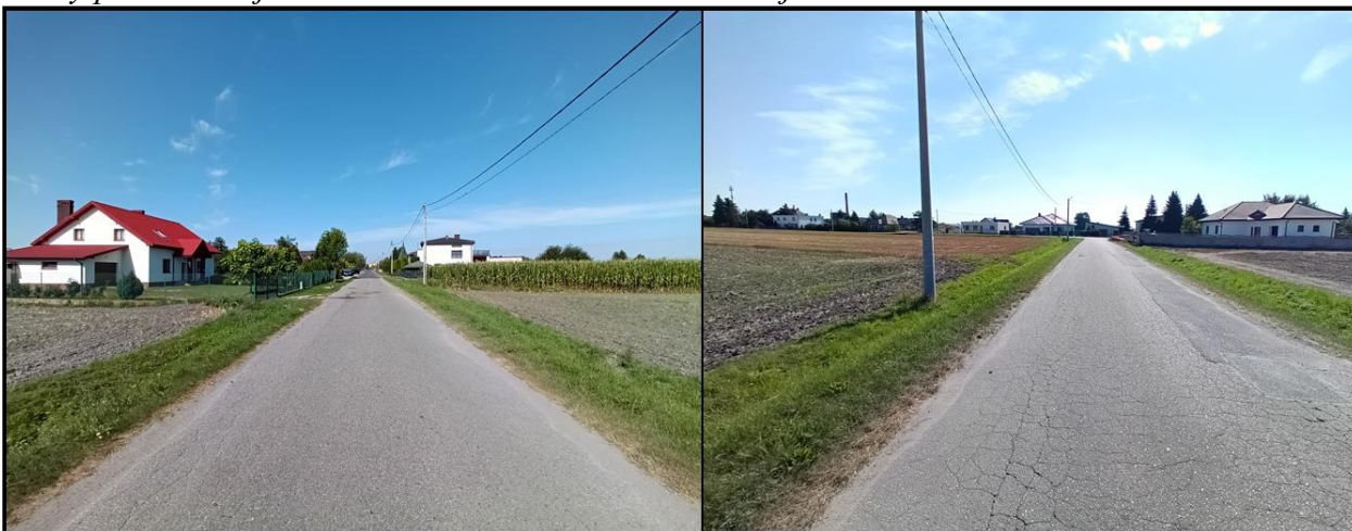
Widok na drogę o nawierzchni bitumicznej, graniczącą z terenem planowanej inwestycji od strony południowej. Widoczna zabudowa mieszkaniowa jednorodzinna wsi Kamień
