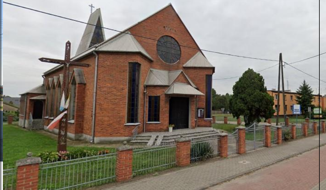
Zdjęcie 10. Kościół pw. Św. Mikołaja w Kamieniu
