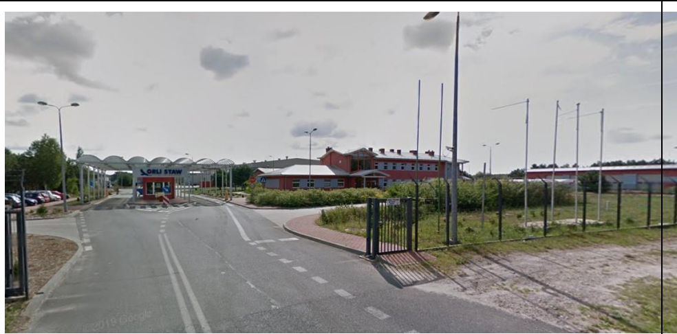
Zdjęcie 5. Zakład unieszkodliwiania odpadów „Orli Staw”
