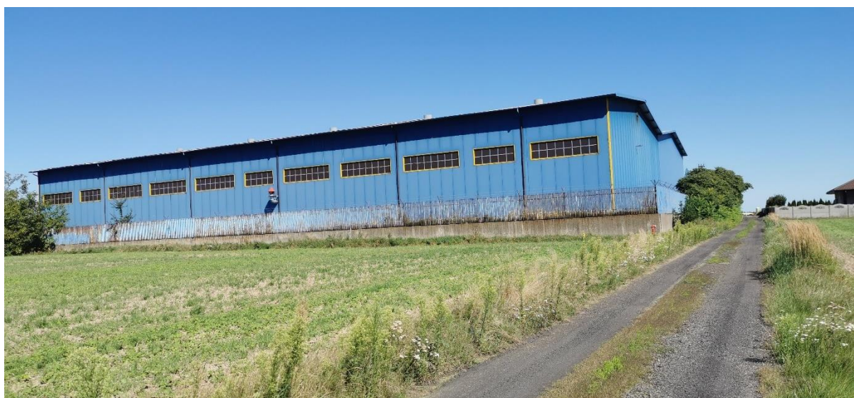
Ryc.8: Widok z terenu przedsięwzięcia w kierunku północno-zachodnim na magazyny (źródło: materiały własne).
