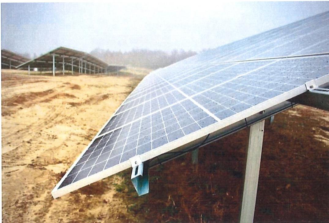
Zdjęcie 2 Panele fotowoltaiczne montowane na konstrukcji wsporczej
