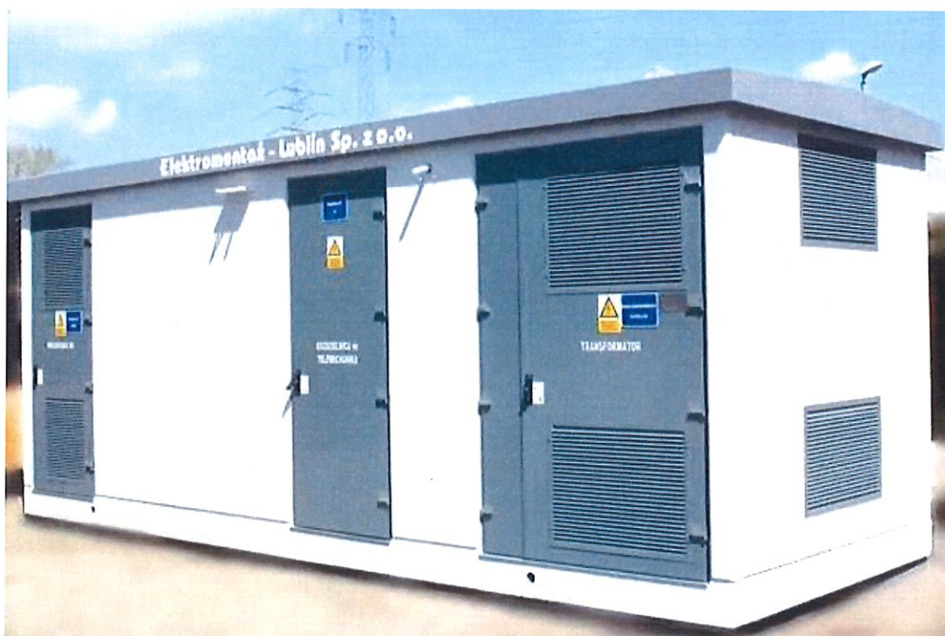
Zdjęcie 3 Budynek stacji transformatorowej
