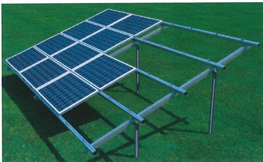
Rys. 20. Konstrukcja wsporcza oparta na podwójnych profilach wbitych bezpośrednio w grunt.
