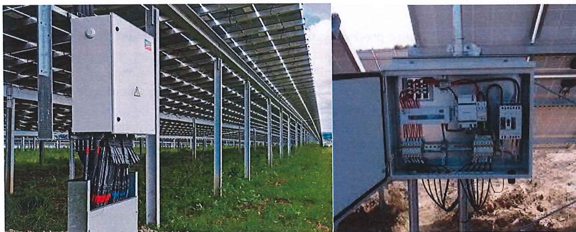
Rys. 21. Przykład String-boxa.
