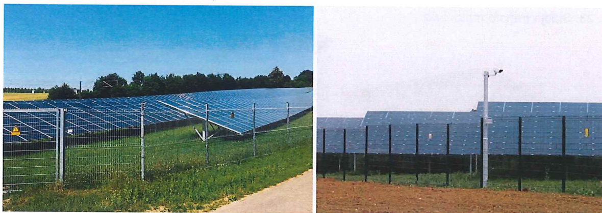
Rys. 24. Ogrodzenie farmy fotowoltaicznej i system monitoringu.
