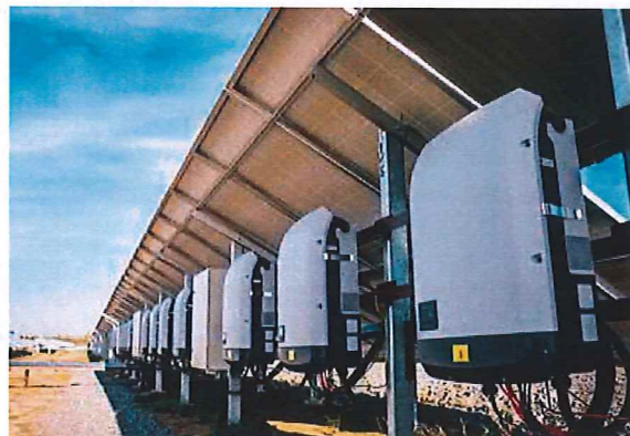
Rys. 22. Inwerter w postaci centralnej (z lewej) oraz w systemie rozproszonym (z prawej).
