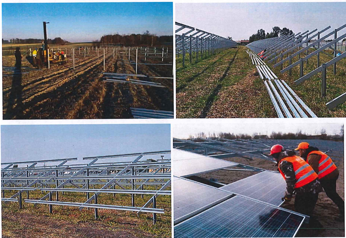
Rys. 25. Budowa i montaż instalacji fotowoltaicznej.
